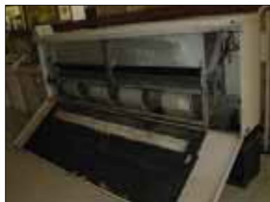
ファンコイルユニット床置型（内部開放）
