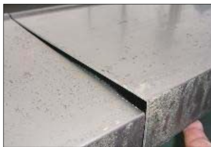
ずれ（金属製）
