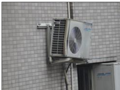
空調室外機の取り付け不良
