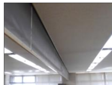
防煙壁（可動式）作動後
