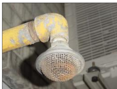
泡消火設備の腐食
