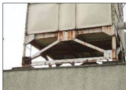
高架水槽の架台腐食
