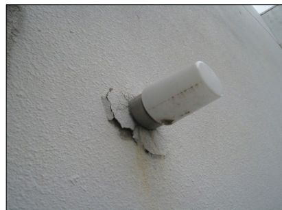
照明器具の取付け部の劣化
