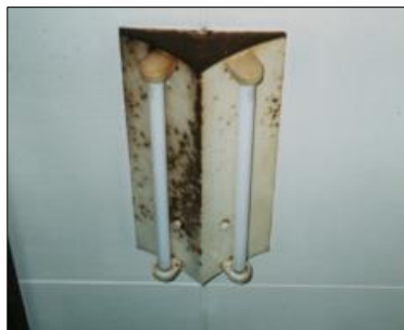
照明器具の腐食
