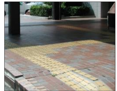
点字ブロックの破損
