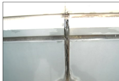
シーリングの剥離・破断（限定的）
