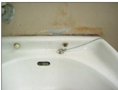
洗面台の取付不良（ＡＹボルト外れ）
