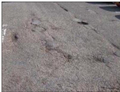
アスファルト舗装面の不陸
