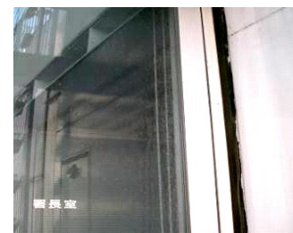
シーリングの剥離・破断（全体的）
