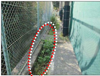
土砂が堆積し、排水不良（側溝）
