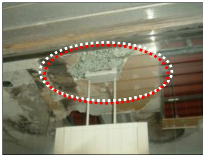
取付け部の劣化
