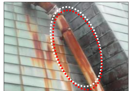
雨樋の取付け部の腐食
