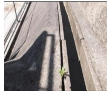
側溝と周囲の隙間
