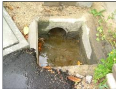
土砂が堆積し、排水不良（排水桝）
