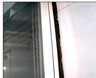
シーリングの破断（全体的）
