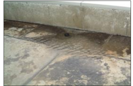
排水口の閉塞による水たまり
