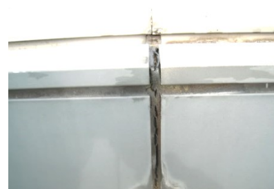
シーリングの剥離・破断（限定的）
