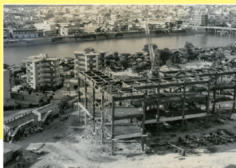
高層アパート建設中。中層の「スターハウス」、川沿いには木造住宅が並んでいます。(1971年／昭和46年)
