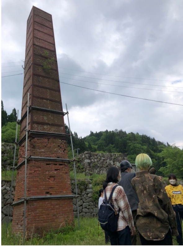
[煉瓦造りの反射炉の煙突が今も残る]
