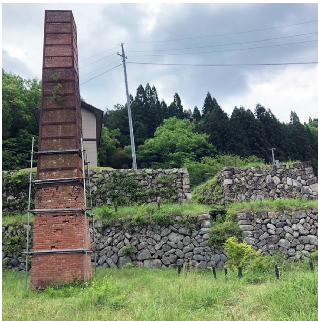
[石垣の段差は、水車の力で溶解炉に送風した名残]
