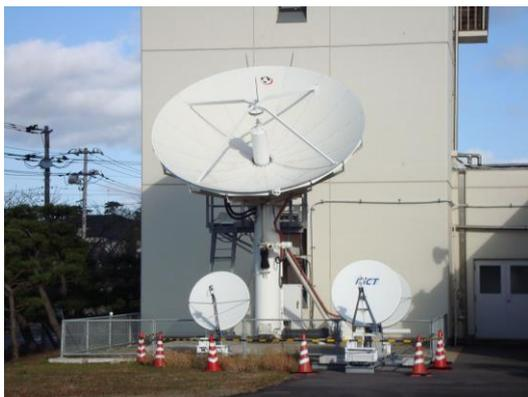
実験に使用した 5m 級アンテナを持つ大型地球局
