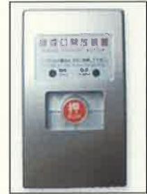
手動開放装置 (機械排煙用)
