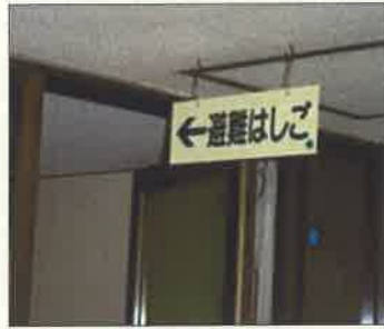
天井等設置物（例）
