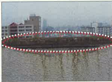
浮き（モルタル製）
