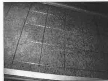
フィルターの目詰まり
