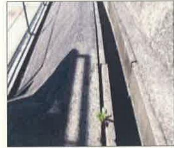
側溝と周囲の隙間
