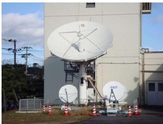
実験に使用した 5m 級アンテナを持つ大型 地球局（中央）(情報通信研究機構 鹿島宇宙技術センターにて撮影)
