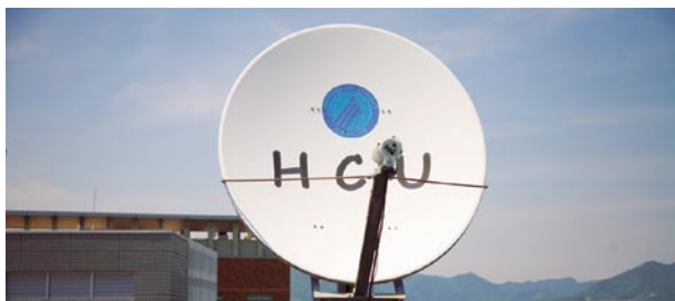
VSAT 地球局 情報工学専攻 これは衛星通信で利用する超小型地球局 (VSAT) の直径 1.8m のアンテナです。この VSAT システムは、比較的小さなアンテナを用いており、災害時における緊急通信路の確保や多地点への映像伝送等を可能としています。
